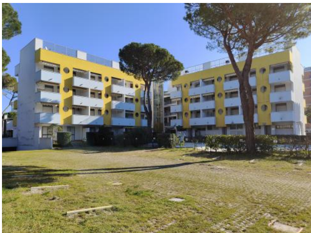
Vista complesso immobiliare retro
